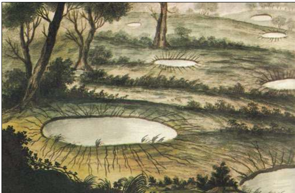
Fig. 5.4.1.2: fenomeni di di liquefazione con formazione di crateri ("sand boils") nei depositi alluvionali sabbiosi nel territorio di Rosarno (RC) verificatosi a seguito del terremoto del 1783.
