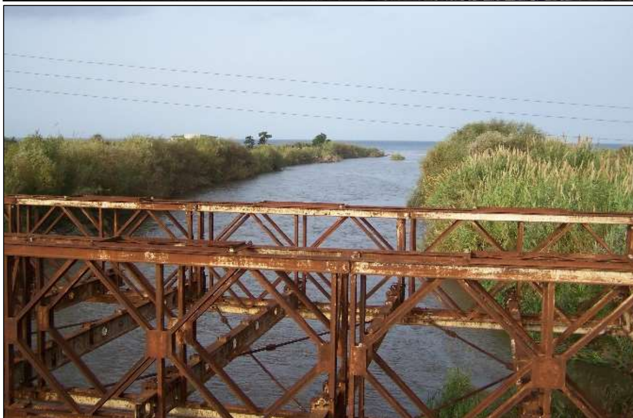
Fig. 6.1.2: report fotografico del reticolo idrografico locale. Foce del F. Mesima (in alto vista verso monte, in basso vista verso la foce).
