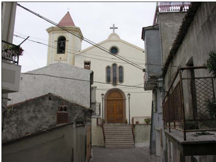
fotografia 1-Facciata principale Chiesa dei S.S. Pietro e Paolo
