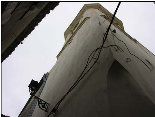
fotografia 5-Torre Campanaria con spigolo di base smussato
