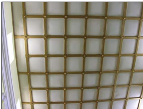
fotografia 4- Particolare 1, copertura a cassettoni
