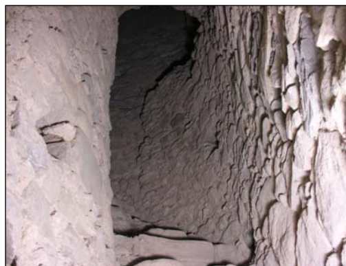
fotografia 13-Particolare 4, scala d'accesso alla cupola della navata centrale
