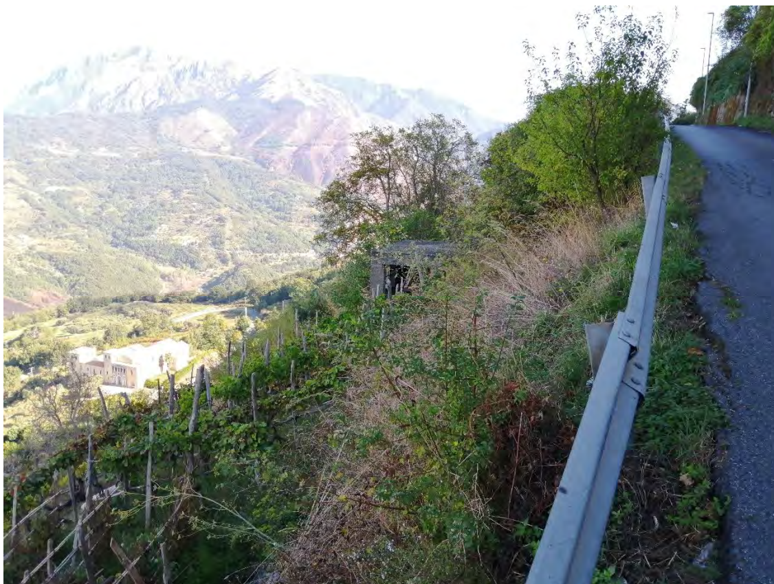
Figura 27. Area soggetta ai lavori in via Galileo Galilei, Bonifati.
