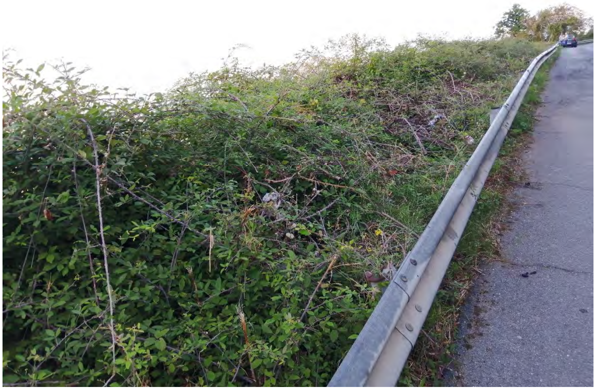
Figura 29. Area soggetta ai lavori in via Galileo Galilei, Bonifati.
