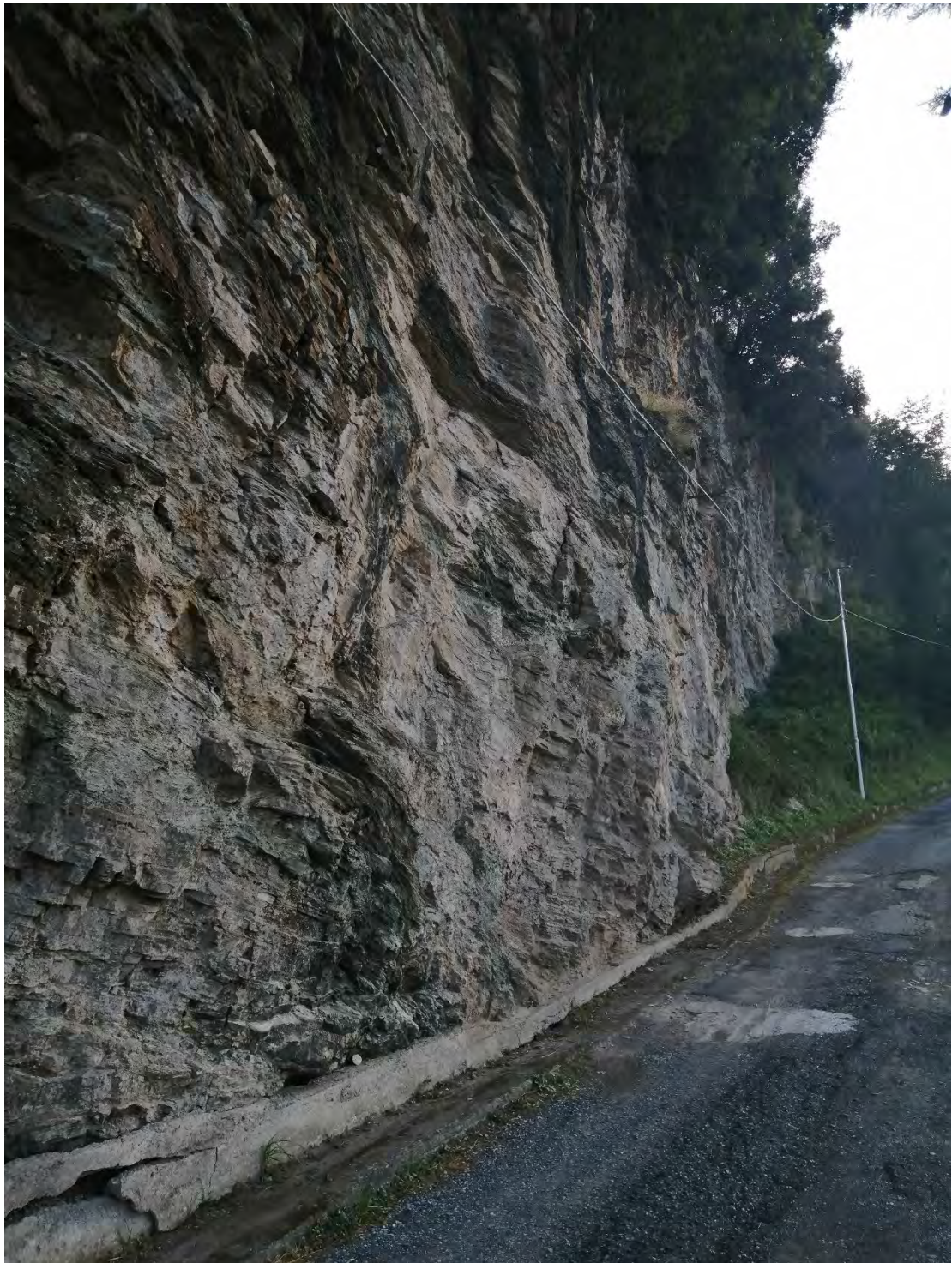
Figura 16. Parete rocciosa soggetta ai lavori in via Vittorio Alfieri, Bonifati.
