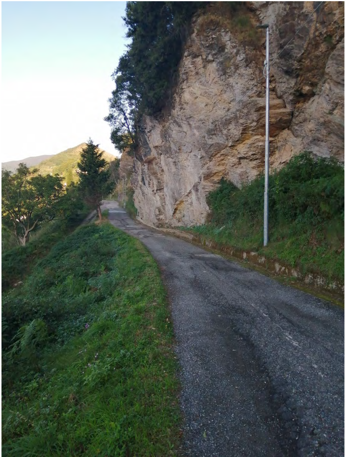
Figura 14. Parete rocciosa soggetta ai lavori in via Vittorio Alfieri, Bonifati.
