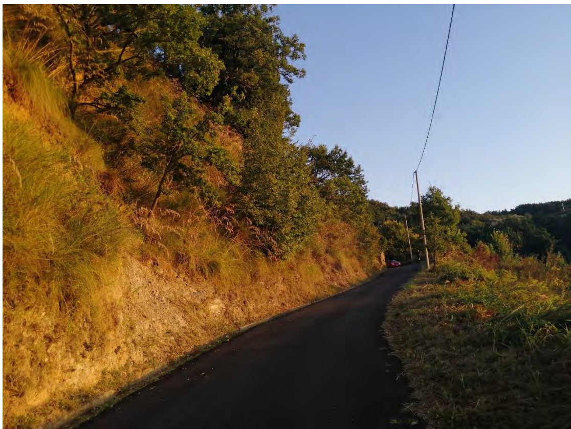
Figura 10. Particolare parete rocciosa interessata dai lavori in via Rivello, Bonifati.
