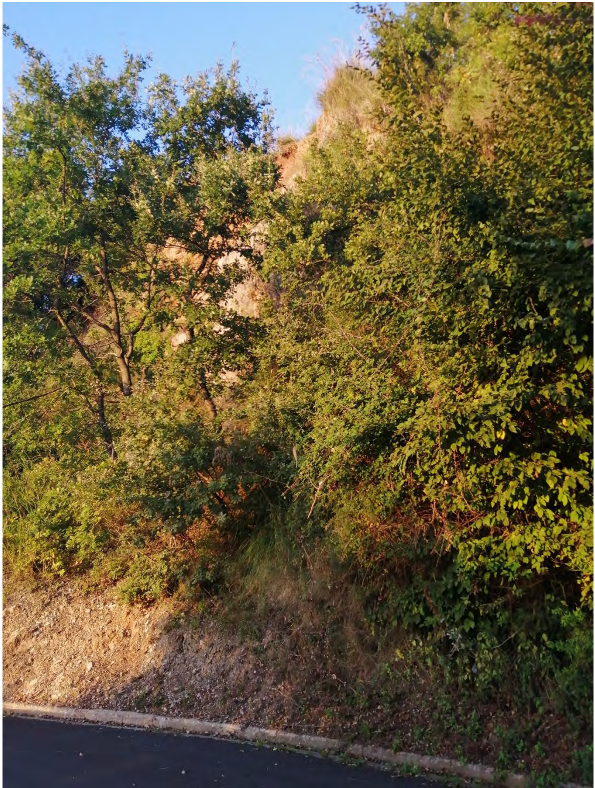
Figura 12. Particolare parete rocciosa interessata dai lavori in via Rivello, Bonifati.
