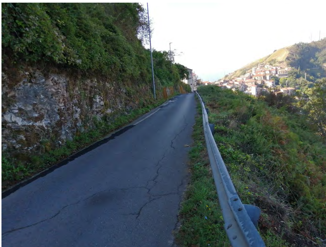
Figura 26. Area soggetta ai lavori in via Galileo Galilei, Bonifati.
