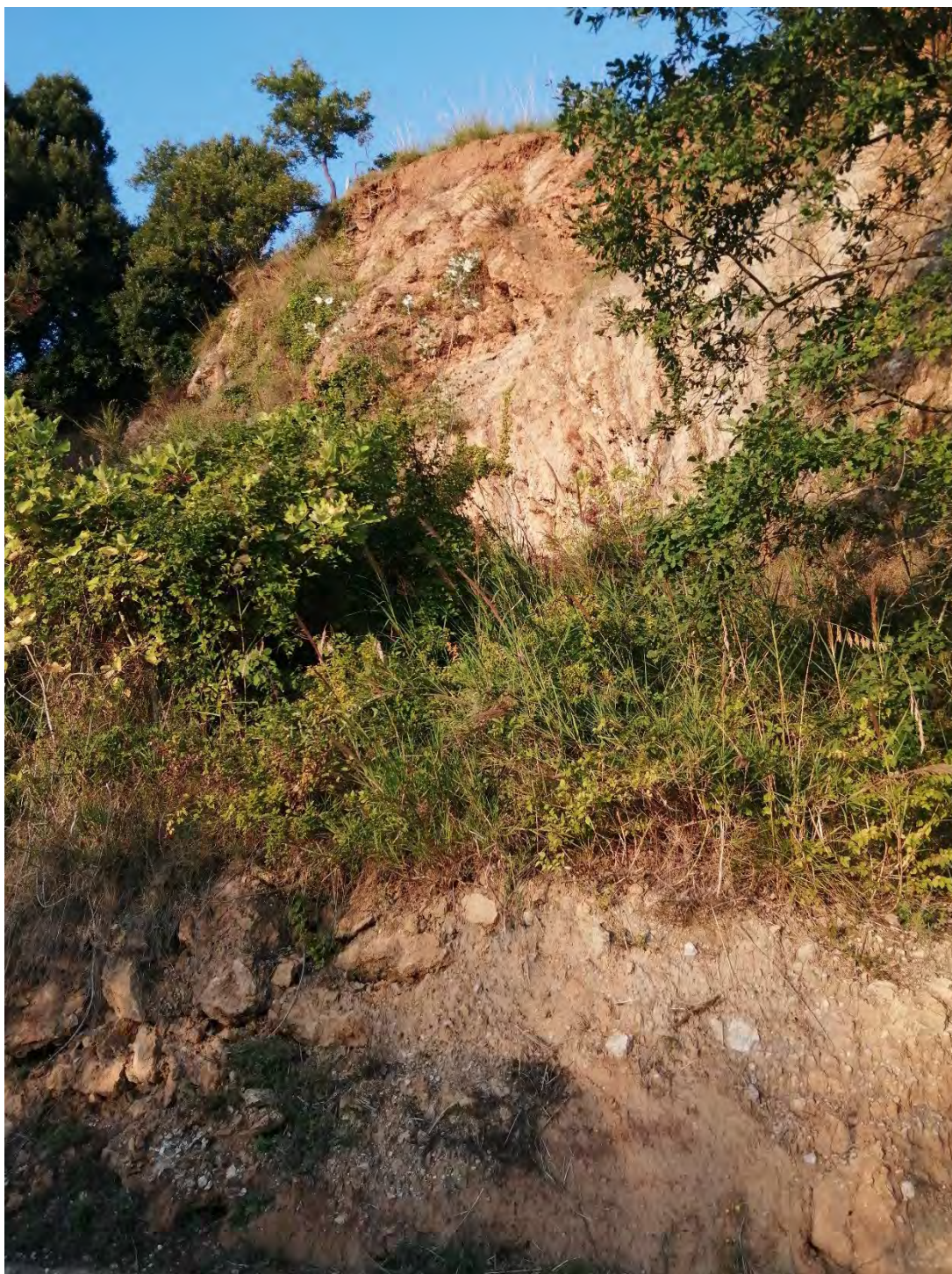
Figura 13. Particolare parete rocciosa interessata dai lavori in via Rivello, Bonifati.
