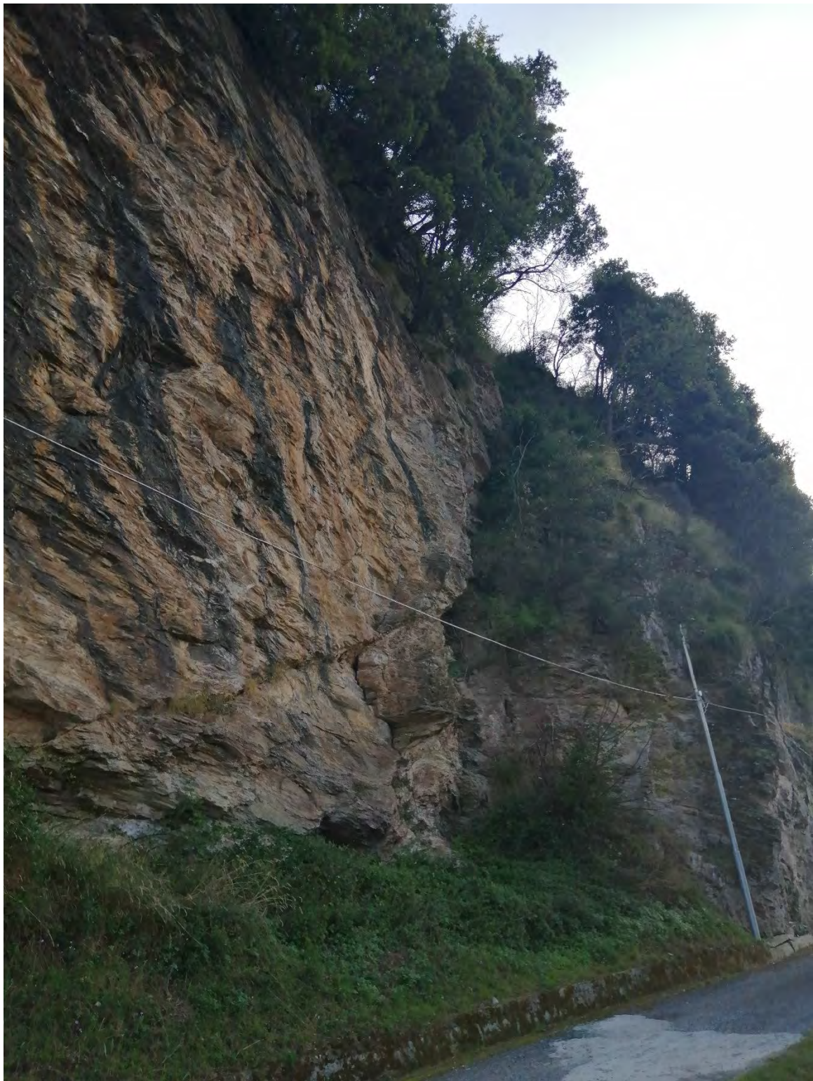
Figura 15. Parete rocciosa soggetta ai lavori in via Vittorio Alfieri, Bonifati.
