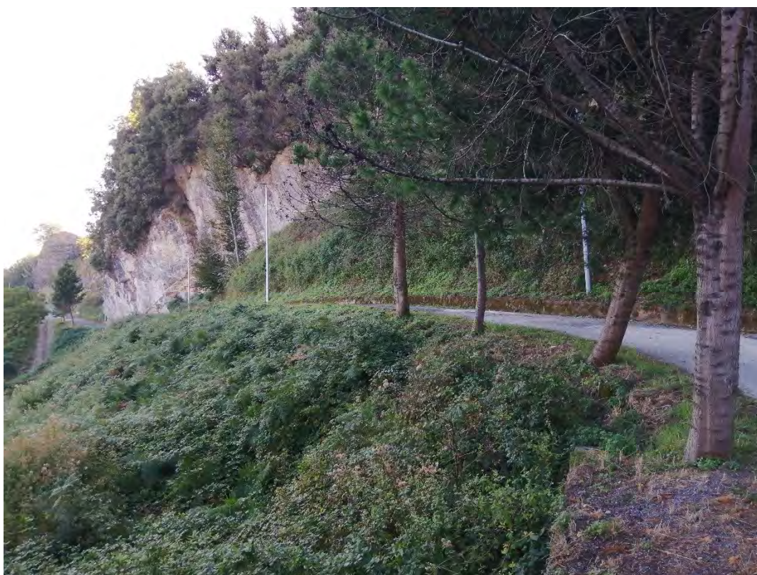
Figura 18. Area sottostante la carreggiata soggetta ai lavori, via Vittorio Alfieri, ingresso cimiteriale, Bonifati.
