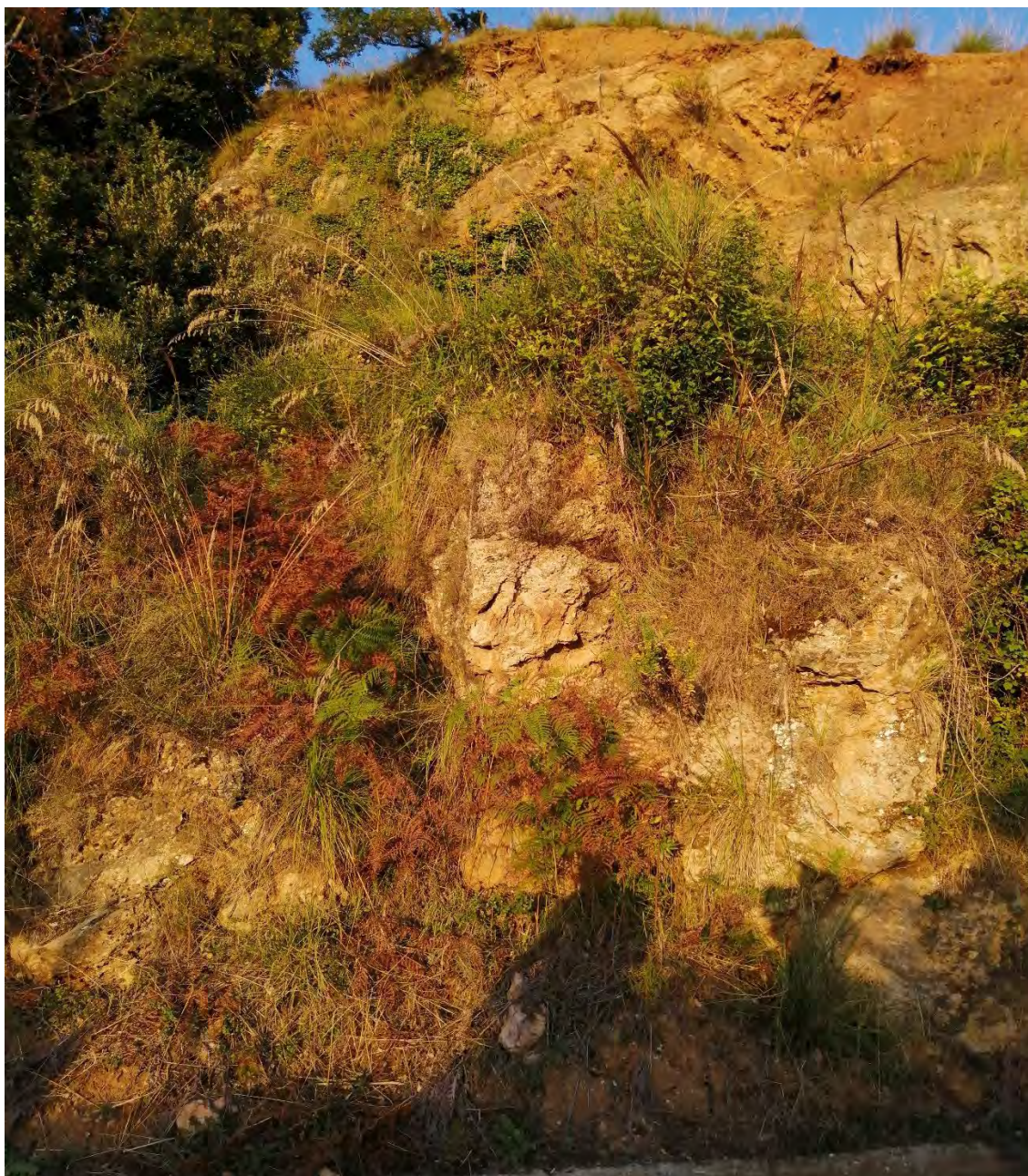
Figura 11. Particolare parete rocciosa interessata dai lavori in via Rivello, Bonifati.
